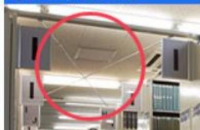
上部水平ブレースにより、複雑な方向からの揺れに対して平面剛性が増します。
