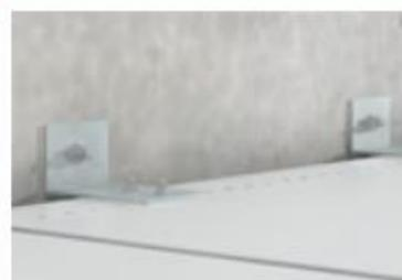
L型金物を使ってアンカーボルトで壁に固定します。
