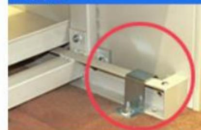
フロア面から床材を貫通させて、建屋躯体にアンカー止めることで、転倒・横ずれを防止します。
