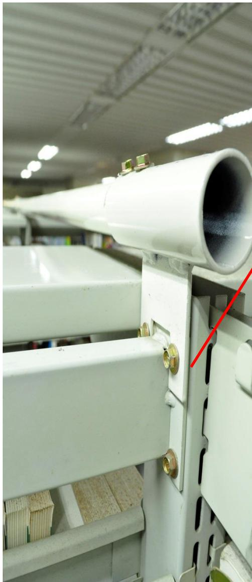
連桿改鎖在書架結構最強的直鋼樑上
